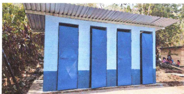
Foto 5: MATENIMIENTO DE PUERTAS METAL, LIJADO, PINTADO
